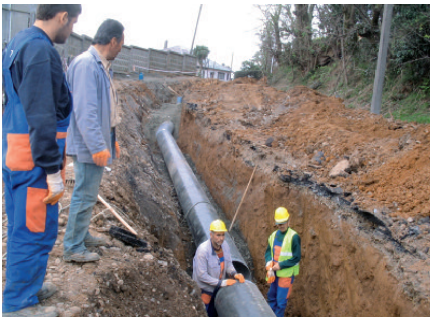
Abb. 3: Bauarbeiten in der Altstadt von Batumi
