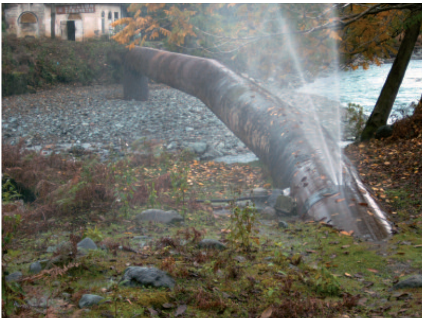
Abb. 2: Marode Wasserversorgungsinfrastruktur
